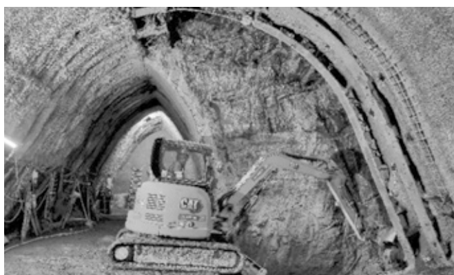
Obr. 4 – fotografie z ražby patní štoly
