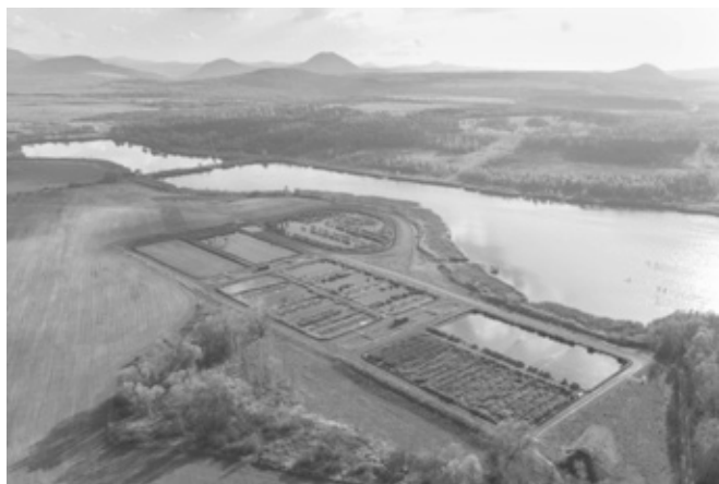
Letecký pohled na celou stavbu
