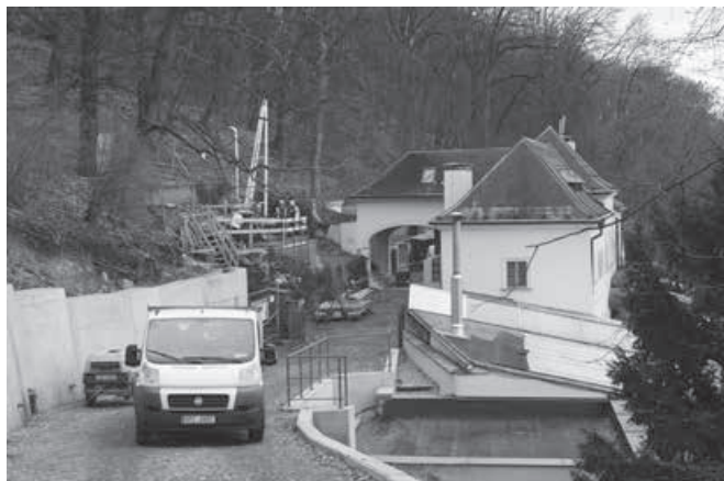
Rekonstrukce štoly za restaurací
