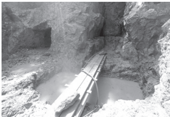
Zatopená ohlubeň šachty
