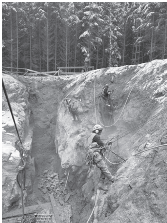
Kotvení nestabilních stěn
