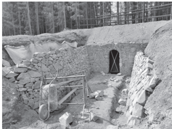
Stavba portálu odvodňovací štolý
