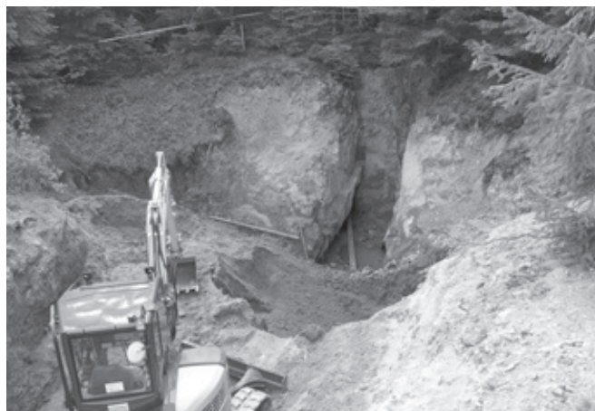
Odkrytí komory pohonného kola vodotěžného stroje
