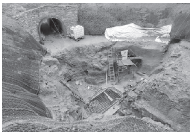
Zajištění opěrné zdi
